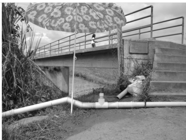
Foto 1. Sifón montado sobre la corona de la presa menor en concepción.
