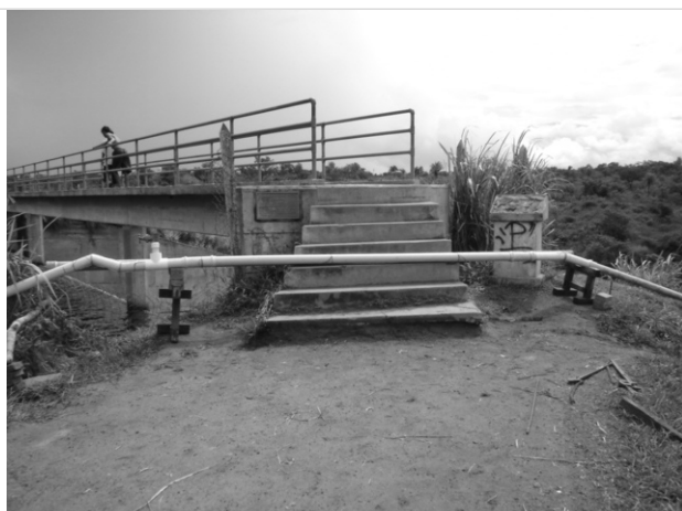
Foto 2. Variación de la elevación del sifón con respecto al NAN.
